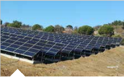
GES Kuvvetli akım MCC ve DDC panoları
